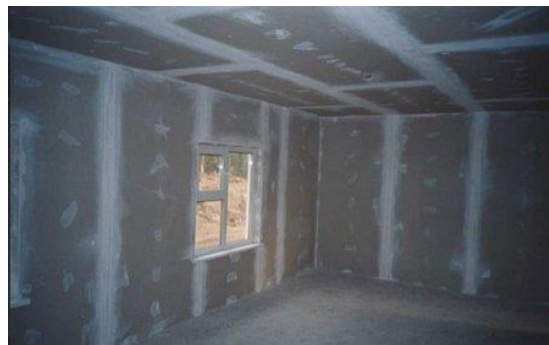
Рисунок 2 – Общий вид комнаты со стенами из монолитного бетона в опалубке из ЦСП (а) и жилого дома (б)
