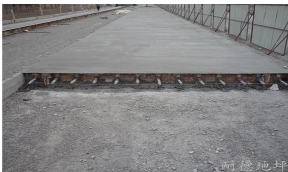
Рисунок 4 – Устройство бетонной дороги
