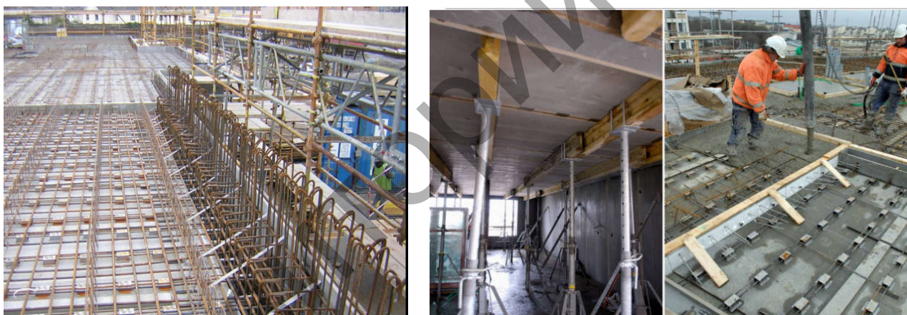
Рисунок 1 – Применение VST-системы перекрытий зданий
