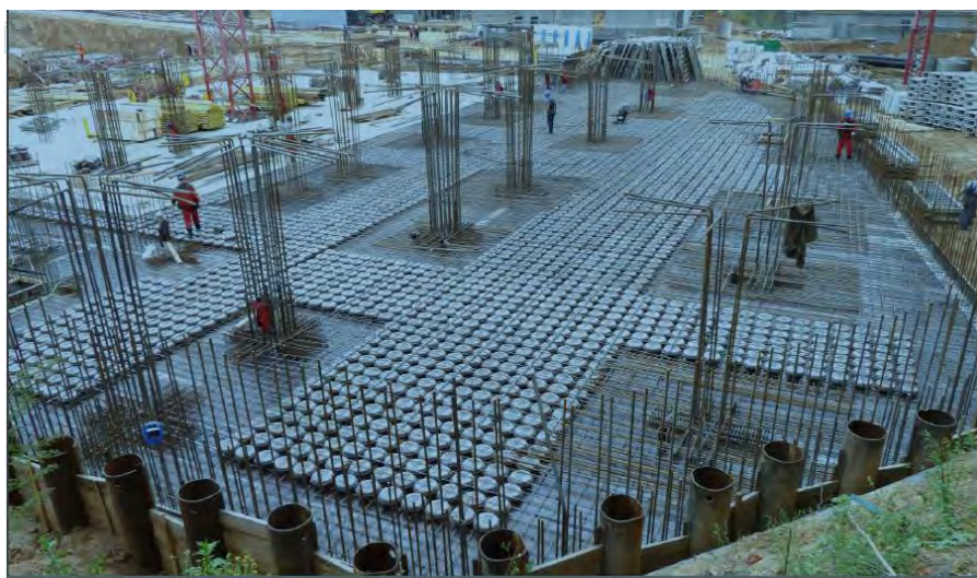
Рис. 1. Применение пустообразователей фирмы «Собіах» в фундаментах
