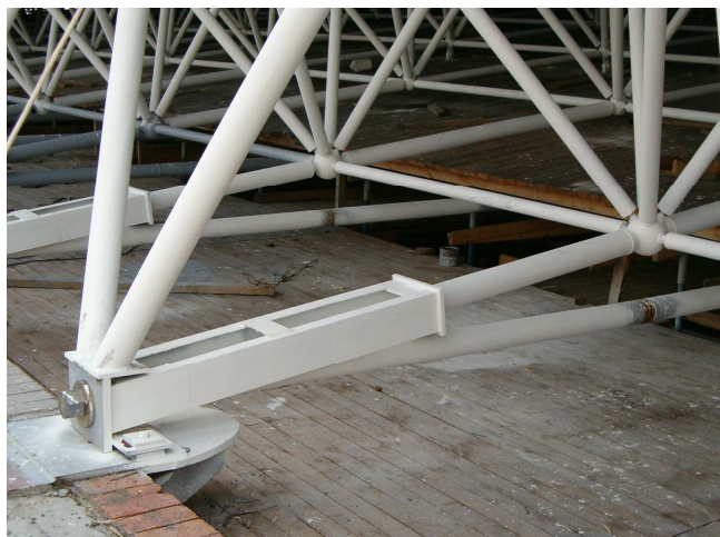
Рис. 5. Узел опирания структуры на колонну (тип 2)
