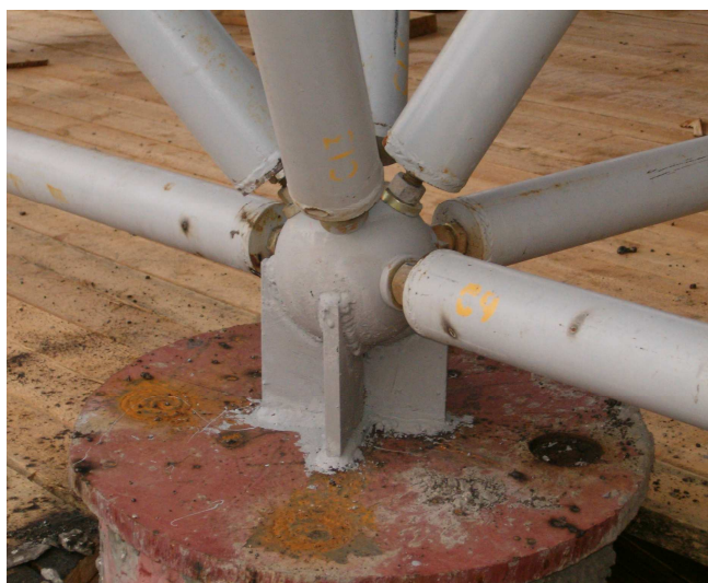
Рис. 4. Узел опирания структуры на колонну (тип 1)
