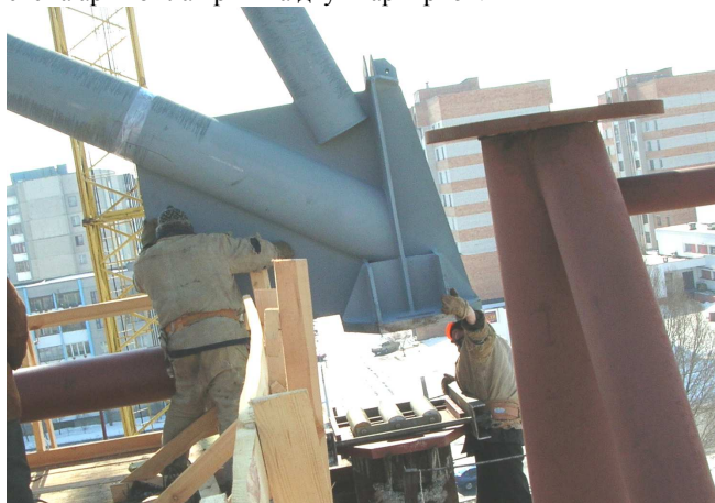
Рис. 4. Монтаж опорного узла арки по оси Y11.
