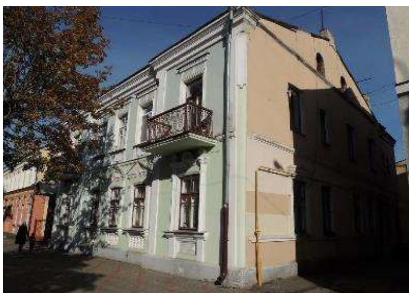
Рисунок 5 – Жилой дом по адресу Карла-Маркса, 66
