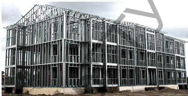
**Рисунок 3** – Несущий каркас жилого здания из ЛСТК
