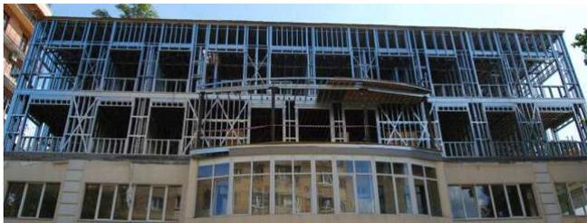
Рисунок 5 – Реконструкция (надстройка этажей) здания с применением ЛСТК
