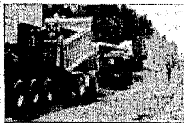
Разогрев старого асфальтобетонного покрытия, фрезерование, выгрузка новой горячей асфальтобетонной смеси в приемный бункер Роудмикса
